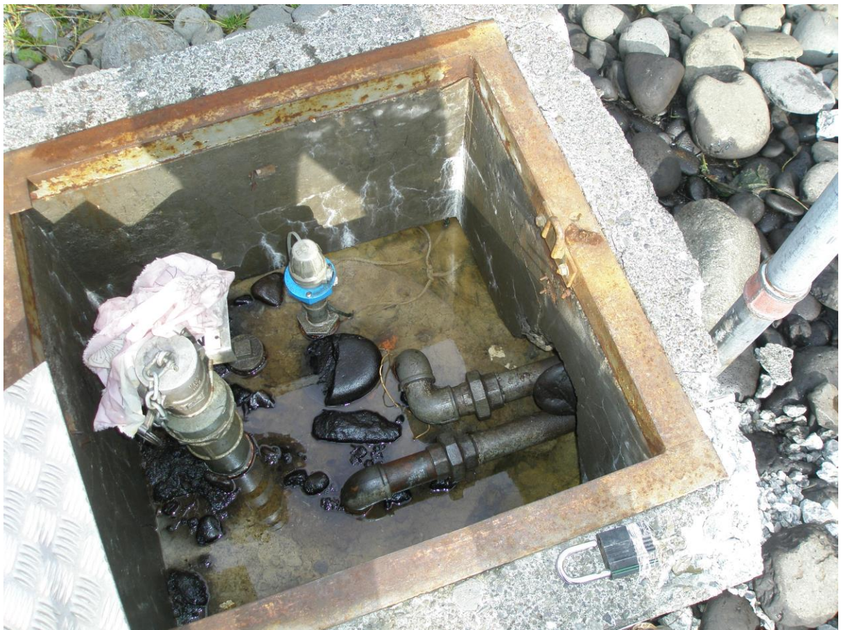
Mynd 5. Áfyllingsbrunnur bensínstöðvar
